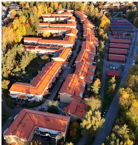
Takreoveringen är klar.
